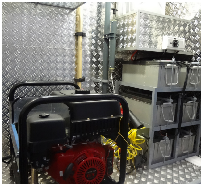
Кормовой отсек с блоком АКБ и генератором
